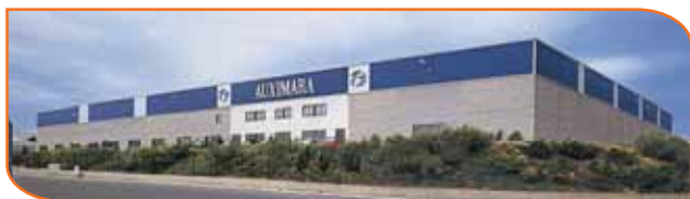
Sede Grupo Auximara (Épila - Zaragoza)
